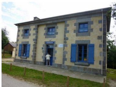
Maison éclusière de Courgalais à Montreuil-sur-Ille
