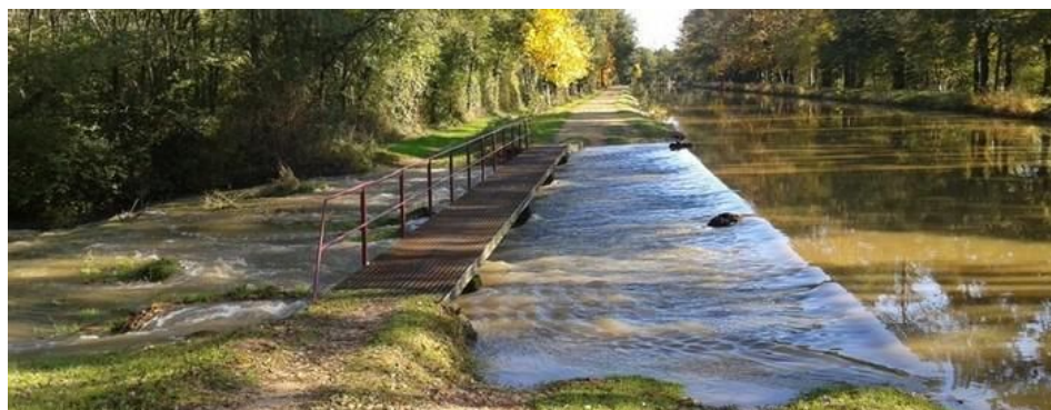
Pont métallique sur déversoir avant La Chevallerais
