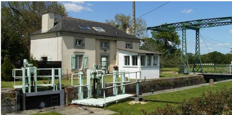
Bruz : écluse avec pont-levis de Cicé
