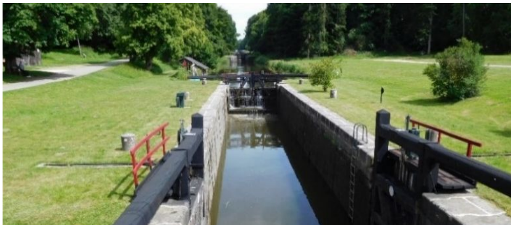
Vue de l'écluse de la Madeleine
