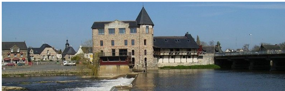
Guipry-Messac : port, ancienne minoterie et déversoir de l'écluse.
