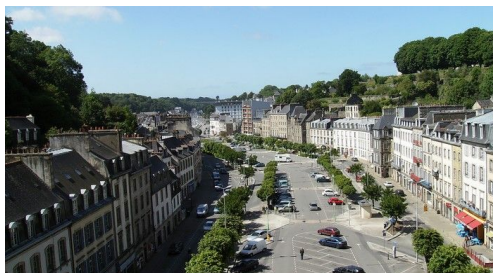
Morlaix, vue vers le nord ; photo prise du viaduc.
