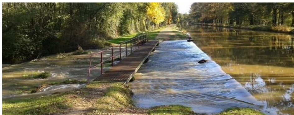
Pont métallique sur déversoir avant La Chevallerais
