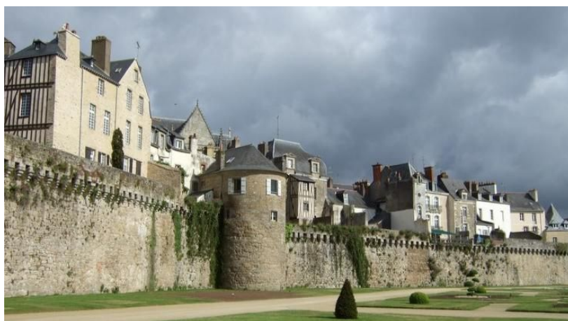
Vannes : une partie des remparts.
