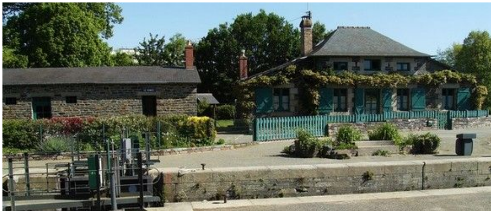
Rennes : écluse Conte
