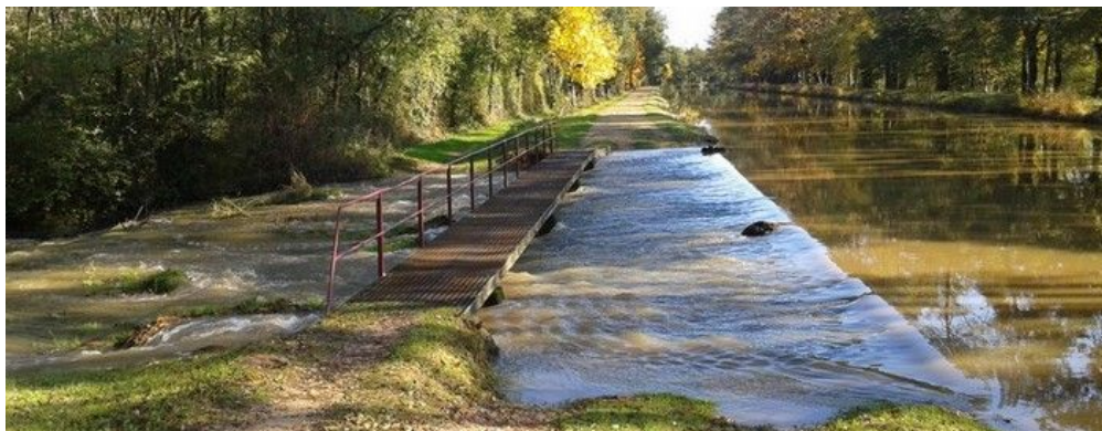
Pont métallique sur déversoir après la Chevallerais
