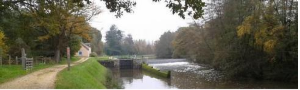
Guenrouët : très belle écluse de la Touche avec son déversoir.
