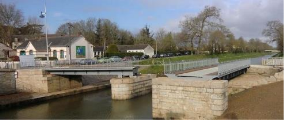
Redon : le pont tournant de voie ferrée, récemment restauré.
