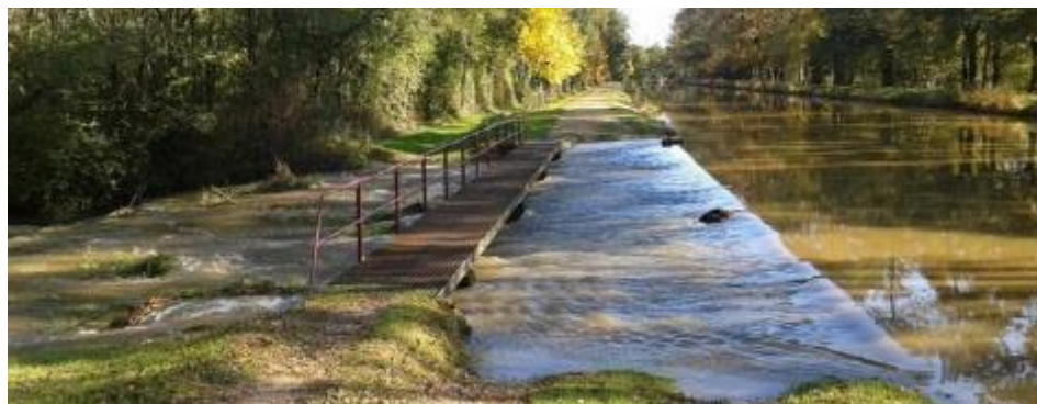
Pont métallique sur déversoir avant La Chevallerai
