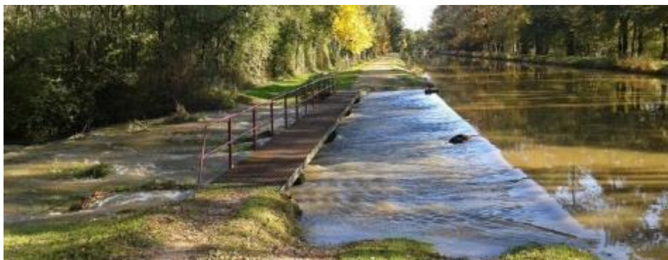
Pont métallique sur déversoir avant La Chevalleris
