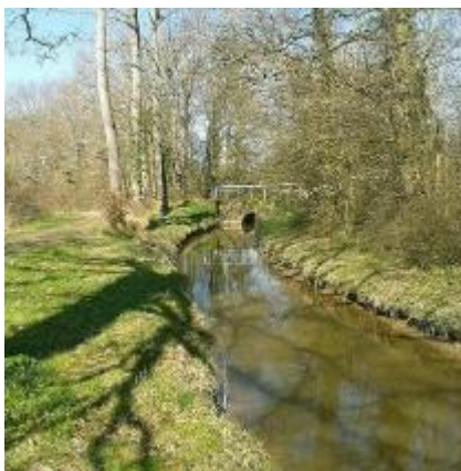
Rigole d'alimentation du Canal de Nantes à Brest avec un pont avec arcade.
